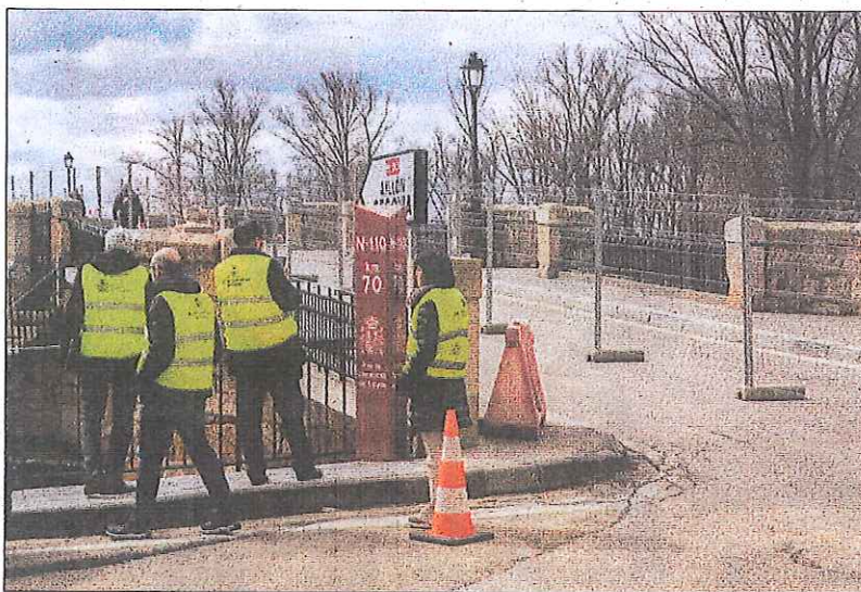
El puente de San Esteban lleva cortado al tráfico desde el derrumbe del 10 de marzo. MARIO TEJEDOR
